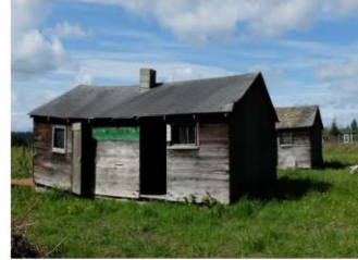
Fig. 24c. NE elevation No.22.
