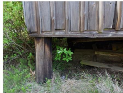
Fig. 9e. Imbedded pole columns.
