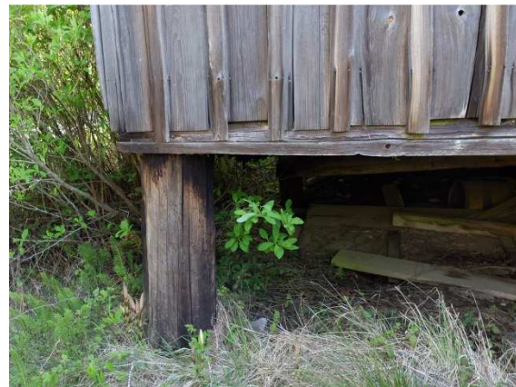
Fig. 9e. Imbedded pole columns.
