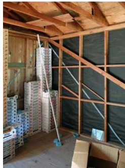
Fig. 12b. SE corner.
