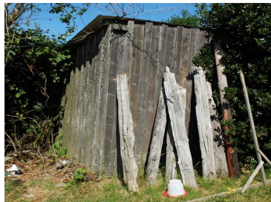
Fig. 28. SW elevation. No.30.
