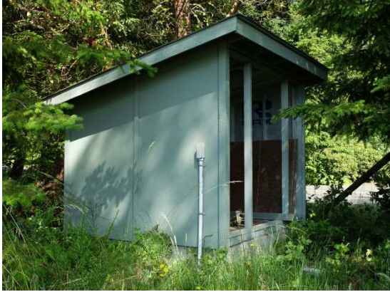
Fig. 25. SW elevation No.25.
